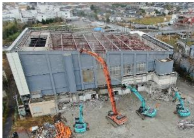
特定復興再生拠点区域での解体工事の様子 (福島県双葉町)
