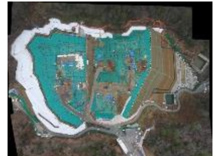
特定廃棄物埋立処分施設の様子
